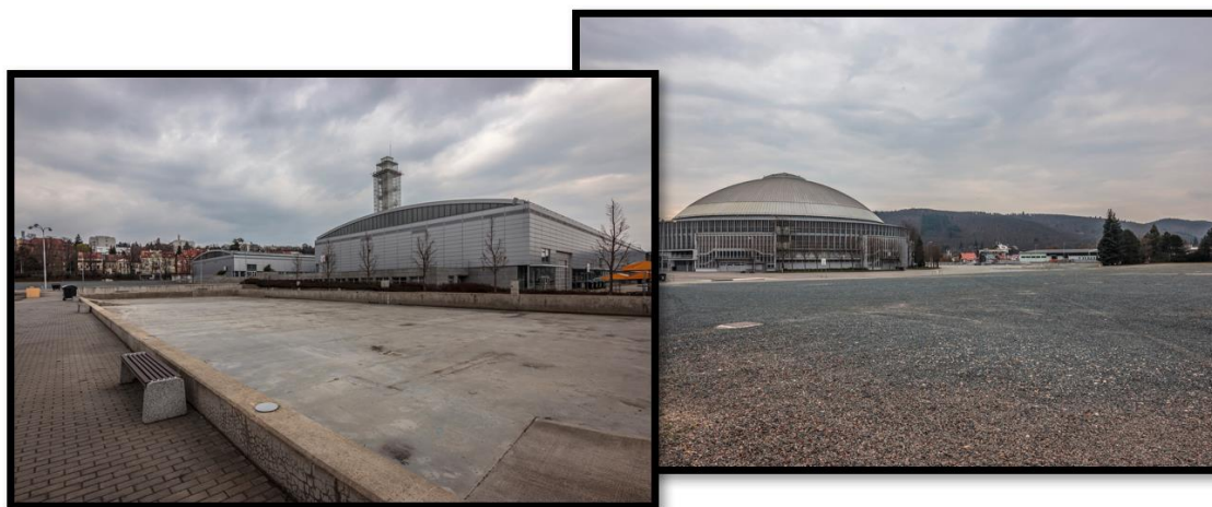
Obrázek 1 Současný stav venkovních prostorů BVV
